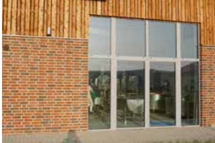
Abbildung 4: Die große Glasfront des Produktionsraums gibt unseren Kund:innen Einblick in die Käserei und bringt viel Licht in den Alltag. Oberhalb befindet sich der Luftfilter mit Heizregister für die Frischluftzufuhr.
